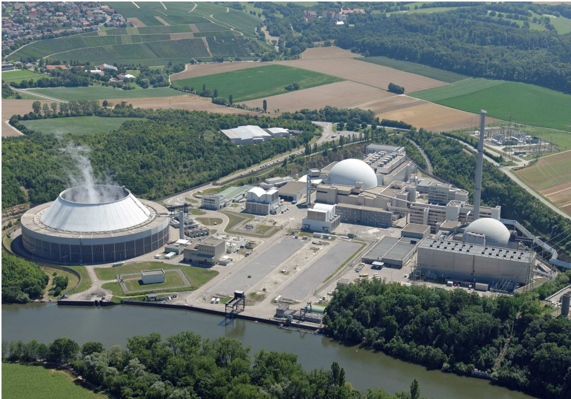
Die Anlagen am Standort Neckarwestheim: Rechts GKN I, in der Mitte GKN II. Auf der Fläche zwischen GKN II und dem Neckar erstreckt sich das Baufeld für Reststoffbearbeitungszentrum und Standort-Abfalllager. Das Standort-Zwischenlager ist – weil es ein unterirdisches Bauwerk ist – auf dem Bild nicht zu sehen. Es befindet sich ungefähr im Bereich des unteren rechten Bildrandes. Das Baufeld für die Schiffsanlegestelle liegt am Neckarufer im rechten unteren Bildbereich.
